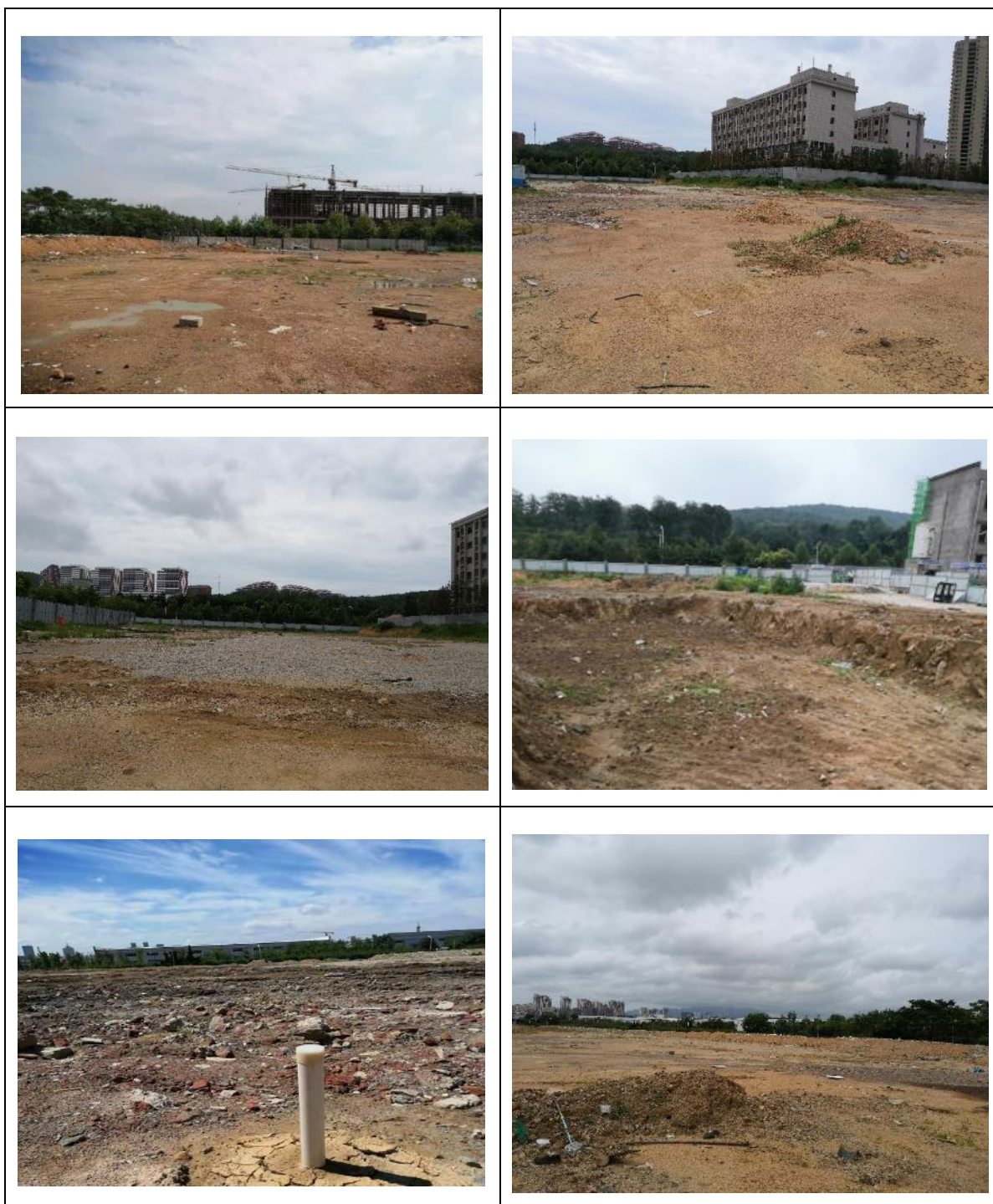
图 3-3 地块现状图（2019 年 8 月）
